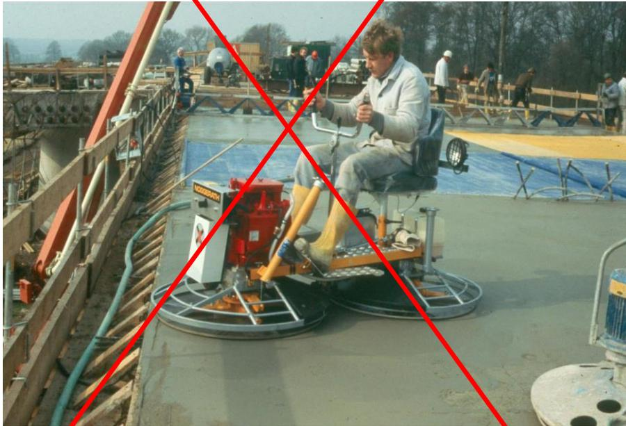
Kein Flügelglätten im Betonstraßenbau, da das Luftporengefüge an der Oberfläche zerstört wird.
