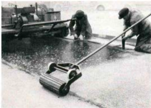
Abb. 4. Riffeln der fertigen Oberfläche mit einer Stachelwalze
