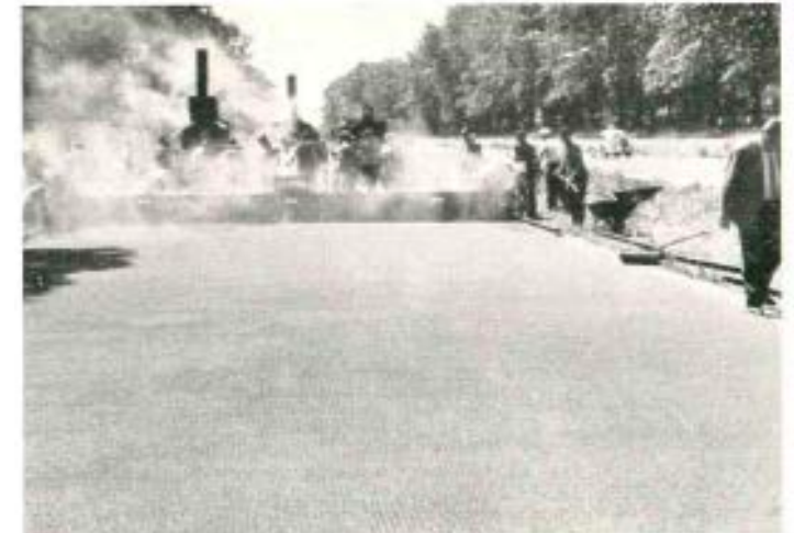
Abb. 30. Maschinelle Verlegung von Gussasphalt auf der Aven mit der Kemna-Bohle
