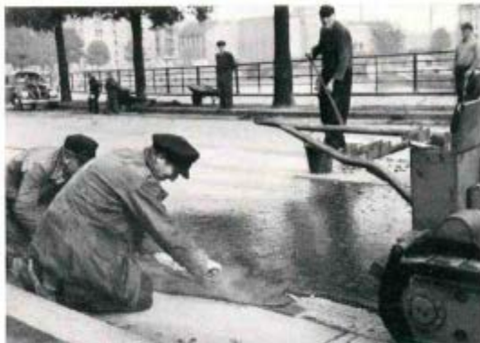
Abb. 3. Anschließen des Hartgussasphaltes an den verbliebenen Stampasphalt
