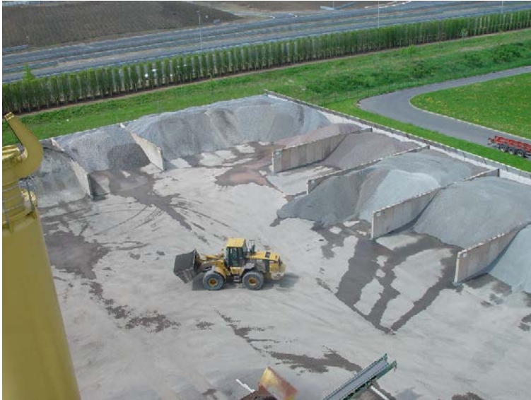
Lagerung in Boxen nach Lieferkörnungen
