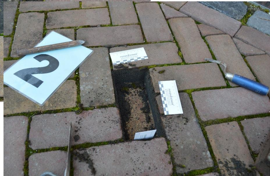
**Beispiel 9: Feinanteile aus Fugenmaterial „wandern“ bei lockerer Lagerungsdichte direkt unter den Klinkerstein**
