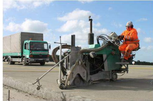
Fugenschnitt über Dübeln und Ankern
