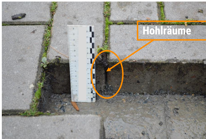
Beispiel 1: Oberflächlich sichtbar gefüllte Fugen, tatsächlich Hohlräume Querschnitt
