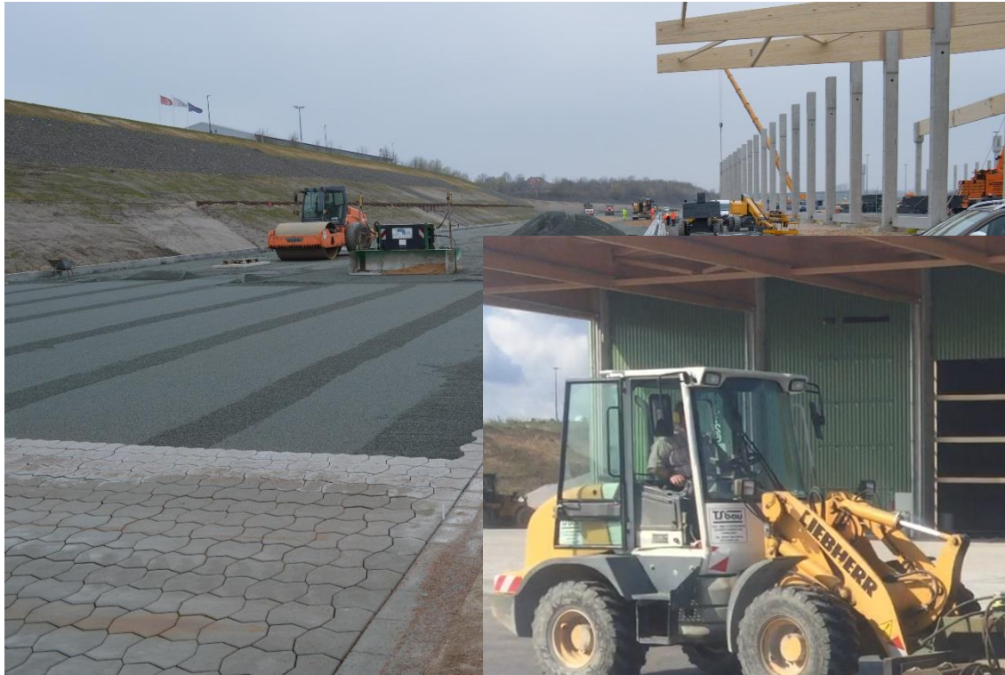
Beispiel 11: Herstellung von Industrieflächen
