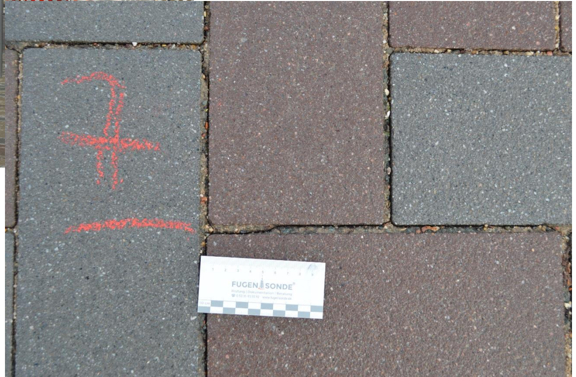
Beispiel 10: Flankenabriß des ungebundenen Fugenmaterials bei Betonsteinen
