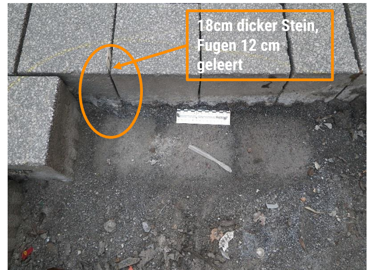
Beispiel 2: 12 cm geleerte Fugen bei einem 18 cm dicken Stein
