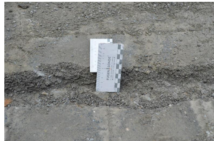
Beispiele 5: Busverkehrsfläche mit Fugen- und Bettungsmaterial nach ZTV und TL Pflaster
