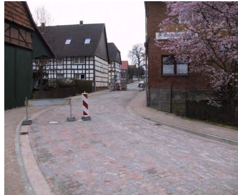
Fugensand auf der Fläche nach der Herstellung, um ein „natürliches“ Nachschlämmen bzw. Verfestigen der Fuge zu ermöglichen
