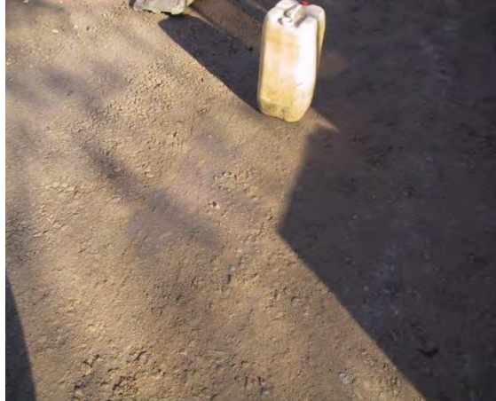
Schottertragschicht gemäß ZTV SoB-StB 04
