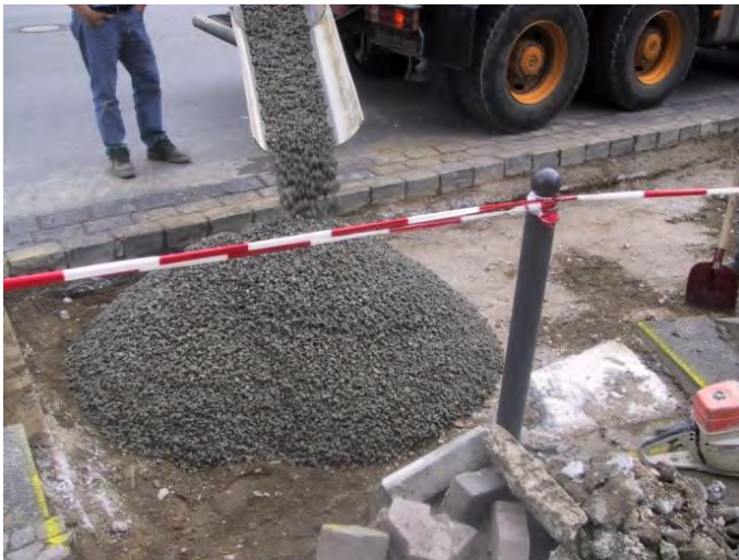
Dränbeton 2/16 mm beim Entladen
