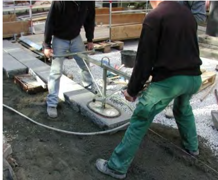
Abb. 1: Verlegung einer Natursteinplatte mittels Vakuum-Verlegegerät
