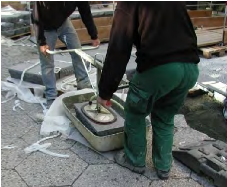
Abb. 1: Verlegung einer Natursteinplatte mittels Vakuum-Verlegegerät
