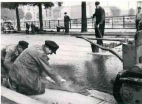
Abb. 3. Anschließen des Hartgussasphalts an den verbleibenden Stampasphalt
