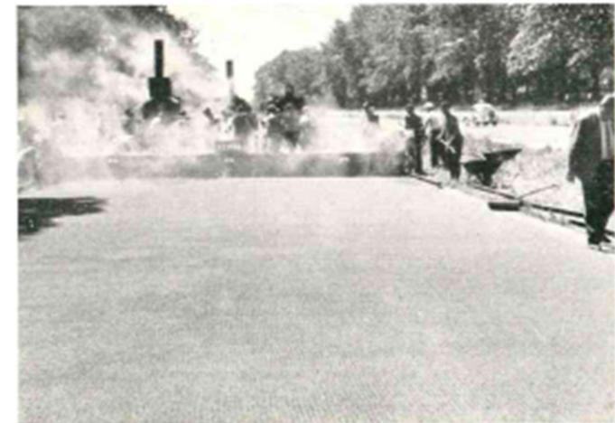
Abb. 30. Maschinelle Verlegung von Gußasphalt auf der Avus mit der Kemna-Bohle
