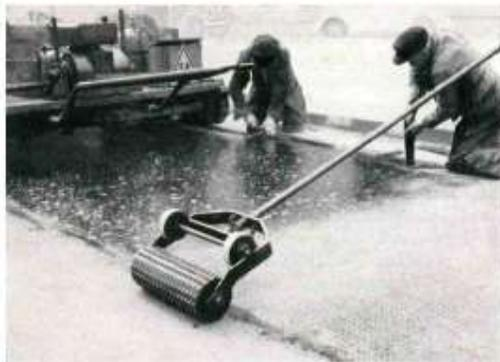
Abb. 4. Riffeln der fertigen Oberfläche mit einer Stachelwalze
