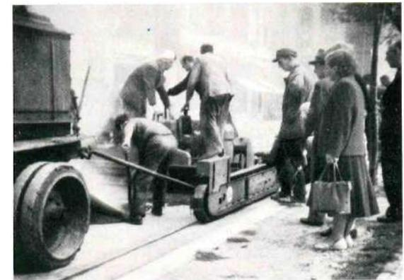
Abb. 1. Vorlegen des Hartgußasphaltes mit Hilfe einer Auslauschurre, angehängt am Motorkecher
